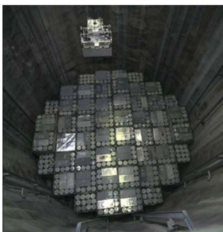
Scorie di basso e medio livello nel deposito geologico di Olkiluoto, Finlandia. ©SKB, Svezia
