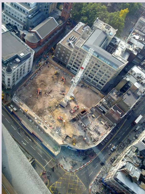
Il cantiere della linea Crossrail a Tottenham Court Road, Londra.
